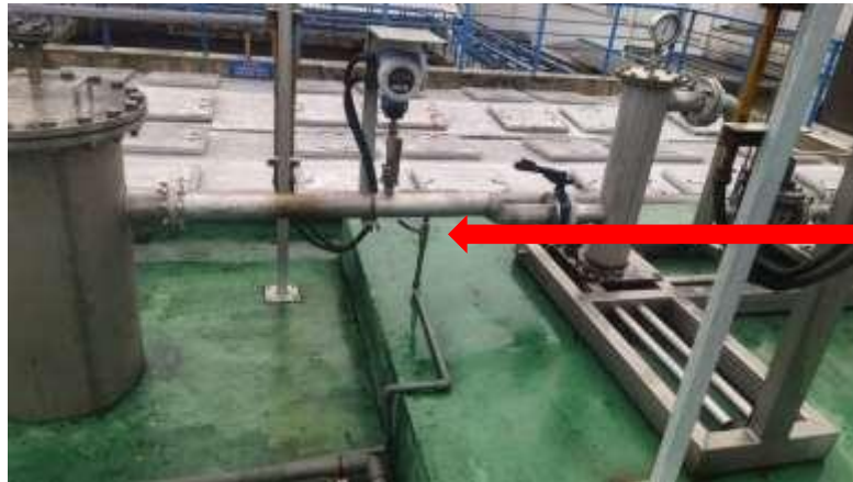
Hasil pemasangan pipa saluran gas
